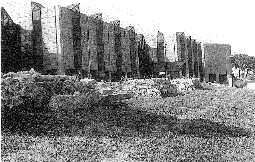
Neubau des Museo Regionale (Nazionale) in Messina mit davor befindlichen Resten des ehemaligen Klosters San Salvatore dei Greci. (Aufnahme: Cavaliere Rolf Mader, Acc.; 1998).
